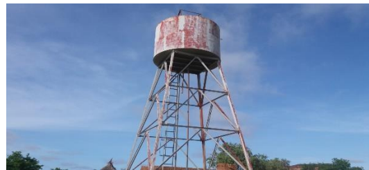
Château d'eau de SONGHO à rénover...
